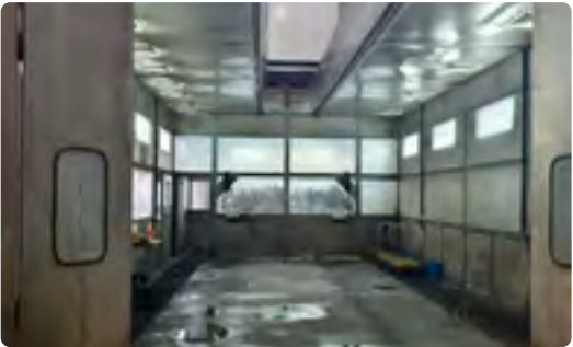
新建高壓水清洗室
