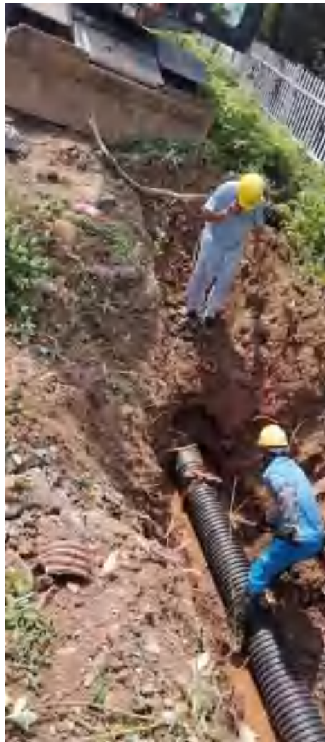
雨污管网改造
